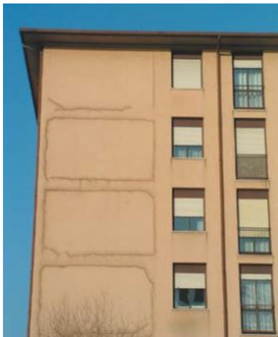
In queste foto alcuni effetti visivi dei ponti termici sia in esterno che all'interno come evidenziato anche dalla termografia
