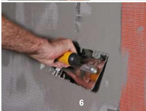
Sistema di isolamento termico esterno a cappotto con pannello in polistirene espanso, utilizzato per l'isolamento termico di edifici sia nuovi che esistenti, e per il risanamento e la protezione di edifici.
