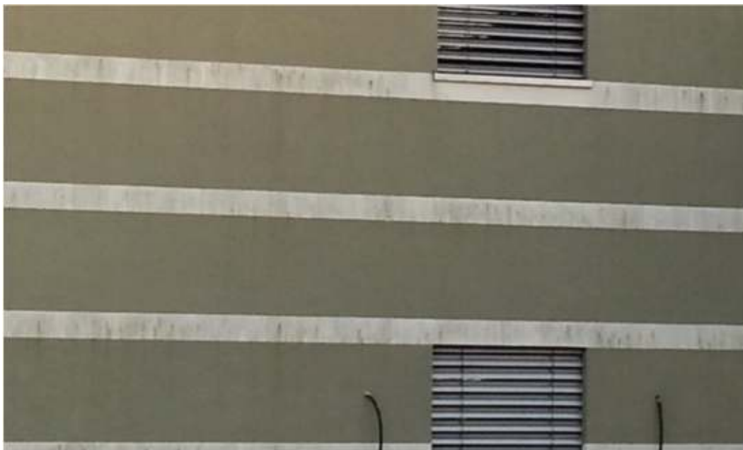
Proliferazione di microrganismi sulle porzioni più chiare della facciata.
